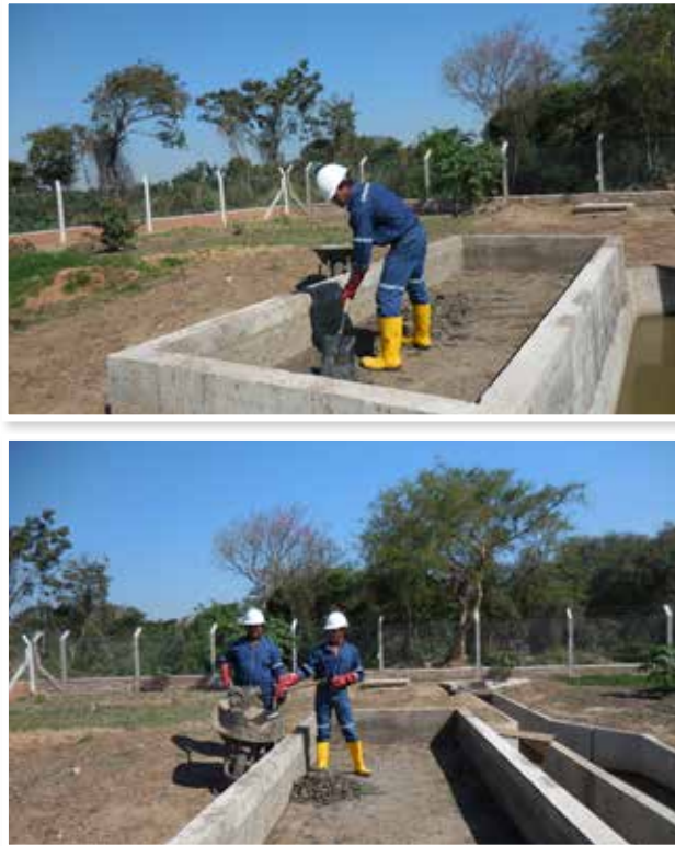
FIGURA 29: EJEMPLO PARA EL USO DE UN LECHO DE SECADO, QUE SE USA PARA EL LODO Y ARENA DEL DESARENADOR , EL AGUA DRENADA FLUYE POR UNA TUBERIA AL DESARENADOR OTRA VEZ MIENTRAS EL LODO SE SECA Y ES TRANSPORTADO A UN ALMACENAMIENTO.
