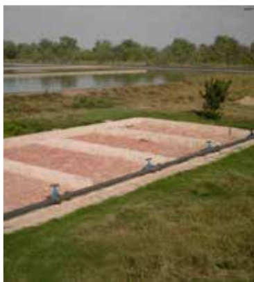
FIGURA 21: LECHO DE SECADO CON DRENAJE . ESTE DISEÑO TAMBIÉN SE PUEDE USAR PARA SECAR LOS RESIDUOS.
