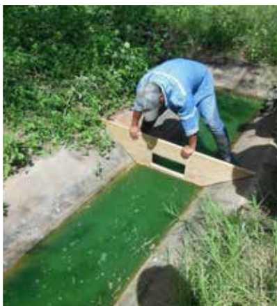
FIGURA 32: INSTALACIÓN DE UN VERTEDERO TEMPORAL CON UNA FORMA RECTANGULAR
