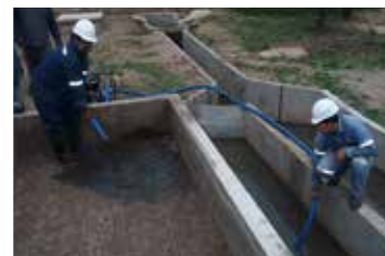
FIGURA 15: LIMPIEZA DE UN DESARENADOR A TRAVÉS DE UNA BOMBA Y UN LECHO DE SECADO
