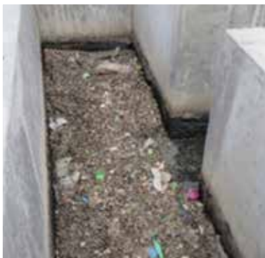
FIGURA 17: CAPA DE GRASA, BASURA Y CARGA ORGÁNICA EN LA TRAMPA DE GRASA.
