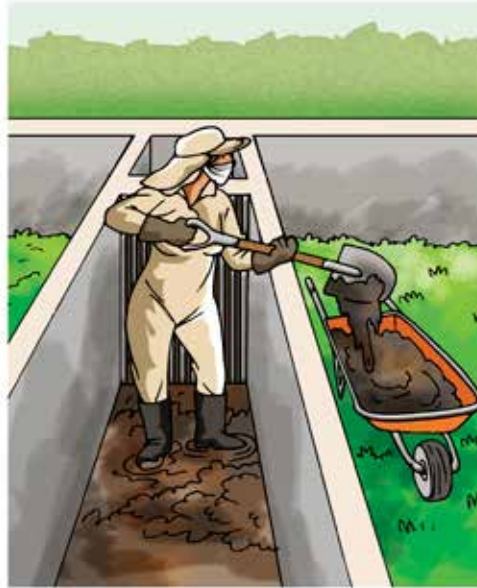
Limpieza de los sedimentos antes de la rejilla:
