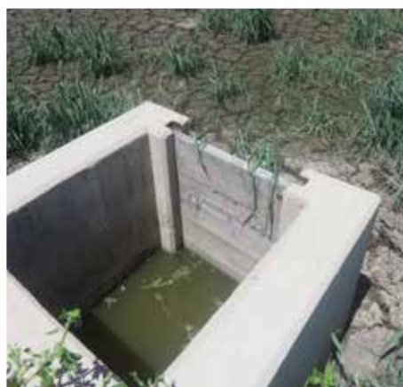
FIGURA 28: AGUA DRENADA EN LA CÁMARA DE LA CUAL SERÁ TRANSPORTADA AL AFLUENTE DE LA PTAR.
