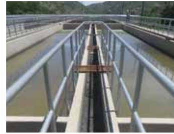
FIGURA 25: TANQUE DE IMHOFF EN SUCRE
