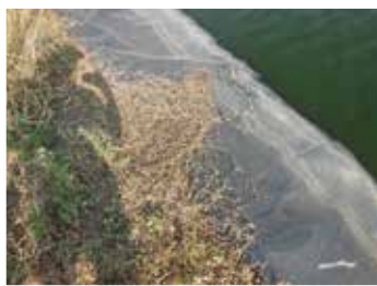
FIGURA 22: VEGETACIÓN DESTRUYENDO LA MEMBRANA IMPERMEABLE DE UNA LAGUNA
