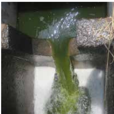
FIGURA 31: VERTEDERO DE AFORO HECHO DE HORMIGÓN
