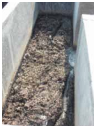
FIGURA 11: TRAMPA DE GRASA CON UNA CAPA DE GRASA Y BASURA ANTES DE LA CÁMARA DE LA DISTRIBUCIÓN.
