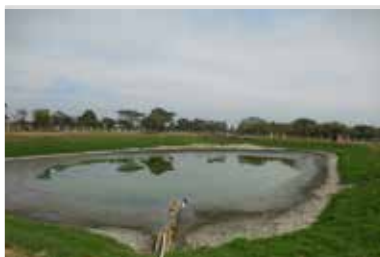
FIGURA 24: PREPARACIÓN DE LA LIMPIEZA DE UNA LAGUNA FACULTATIVA: LA LAGUNA ESTA DESCONECTADA Y ATRAVÉS DE UNA BOMBA SE SACA EL AGUA DETENIDA.
