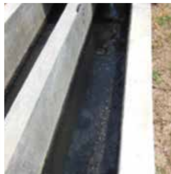
FIGURA 14: DESARENADOR LLENO DE ARENA.
