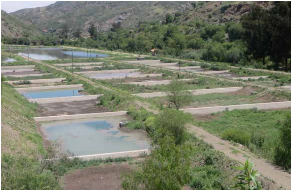
FIGURA 26: LECHOS DE SECADO, PTAR SUCRE
