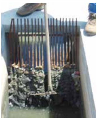
FIGURA 12: LIMPIEZA DE LA REJILLA CON UN RASTRILLO
