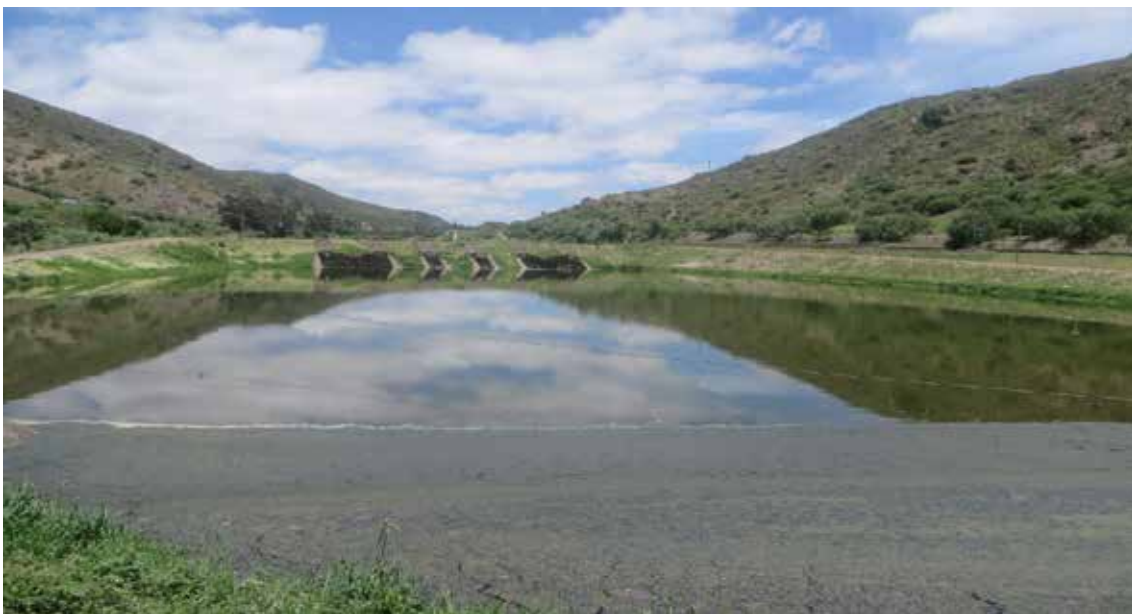
FIGURA 2: PLANTA DE TRATAMIENTO DE AGUAS RESIDUALES EN LA CIUDAD DE SUCRE CON ESCALERAS PARA PROVOCAR QUE ENTRE OXÍGENO
