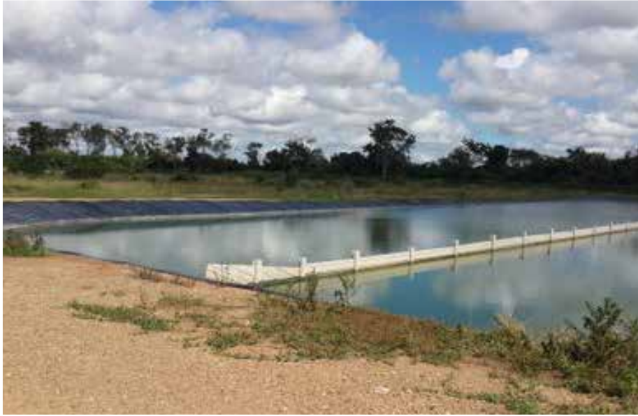
FIGURA 9: LAGUNA DE MADURACIÓN CON LOS BAFLES, QUE INCREMENTAN EL TIEMPO DE RETENCIÓN O DE PERMANENCIA DEL AGUA EN LA LAGUNA, EN UN FLUJO DE ZIGZAG
